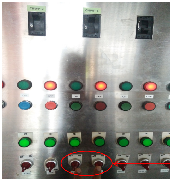
8. กดปุ่ม OFF (สีแดง) ที่ push button switch ของ Cooling Tower (ST 1) -----①
