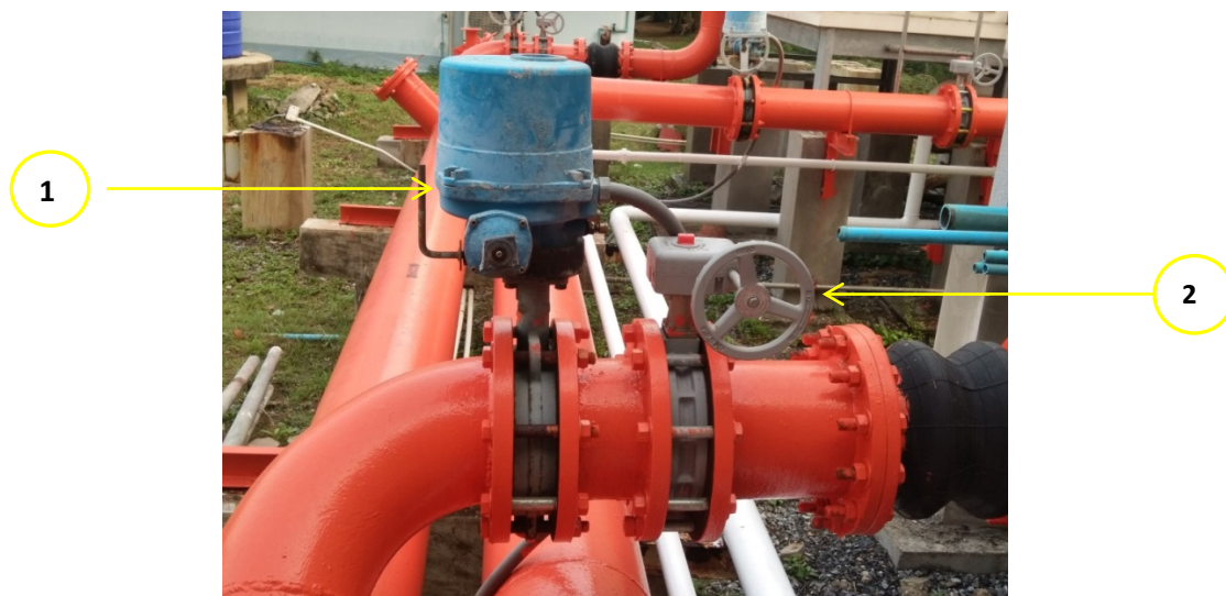
รูปที่ 7 วาล์วไฟฟ้า (1) และวาล์วมือเสือ (2)
