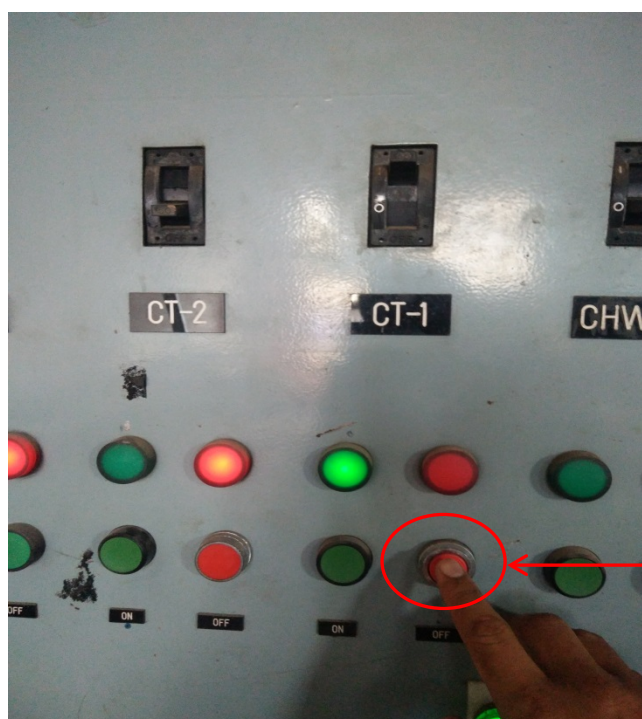
8. กดปุ่ม OFF (สีแดง) ที่ push button switch ของ Cooling Tower (ST 1) -----①
